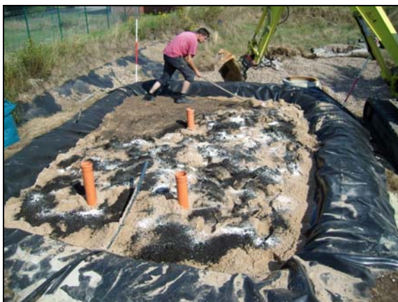
Abbildung 12: Silikatkolloid und Kompost werden oberflächennah gleichmäßig eingeharkt
